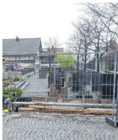
Die Arbeiten am Friedhof Nenzing wurden kürzlich gestartet. EM
